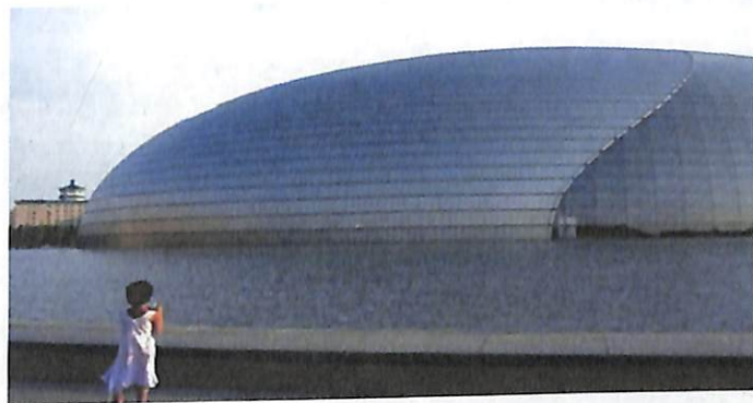
12-rasm. Pekindagi Milliy teatrning gumbazi («Tuxum» nomi berilgan) TiO 2 bilan qoplangan
