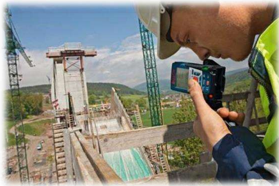
98-rasm. Suv inshootlarini qurishda lazerli dalnomerlardan foydalanish
