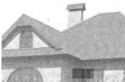
4.8-rasm. Selluloza tolali, qalinligi 2–3 mm li matoni maxsus bitum bilan shimdirib bo‘yalgan tombop to‘lqinli ondulin listi
