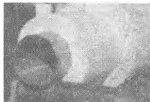
10.14-rasm. Shisha paxtalari bilan harorati 5000 °C gacha, diametri 250 mm gacha bo'lgan temir quvurni izolyatsiyalash
