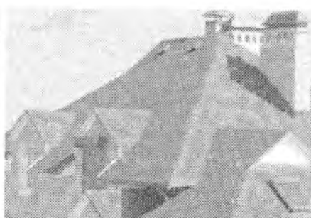
4.5-rasm. Shisha tolali matoni qo‘shilmalar bilan qorishtirilgan bitum bilan shimdirib ishlangan egiluvchan cherepitsa
